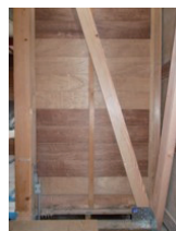
▲耐震改修事例（筋交いによる補強）
